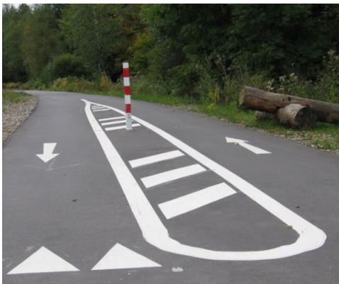
Abb. 1: Beispiel für Poller auf einem Radweg mit auffälliger Farb- und Fahrbahnmarkierung
