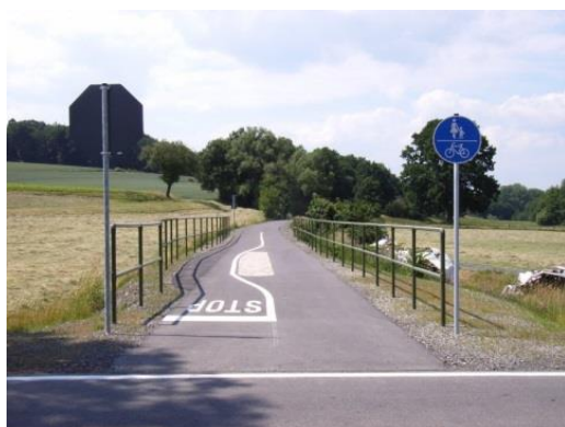
Abb. 7/8: Beispiele für Markierungen auf der Fahrbahn zur Warnung der Radfahrer
