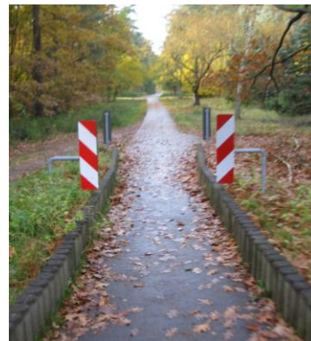
Abb. 5: Barrierefreier Ausschluss von Kraftfahrzeugen durch bauliche Verengung.
