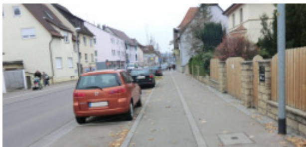
Unsicherer Geh- und Radweg an der Pforzheimer Straße
