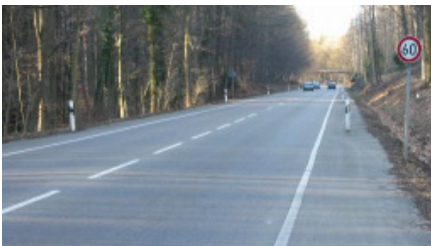
Mittlere Filderstraße: Hier braucht man fast nur die Reflektoren zu versetzen, um je Richtung einen Radstreifen einzurichten
