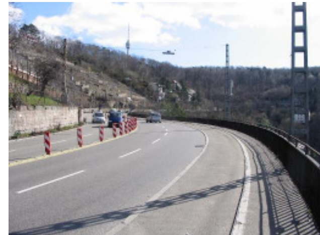
An diesem Teil der Weinsteige sieht es so aus, als bräuchte man nur den Parkstreifen zum Radweg umzuwidmen
