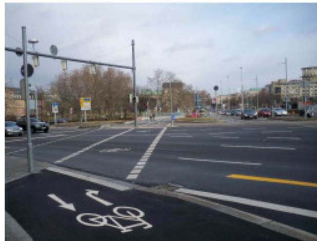
Die neue Querung über den Charlottenplatz
