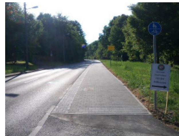
Lückenschluss: Der neue Radweg an der Mönchfeldstraße
