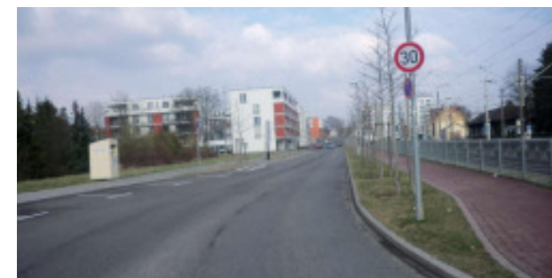
Probststraße: Mit Tempo 30 ist Mischverkehr problemlos
