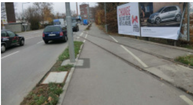
Wernerstraße: Gefährliche Gleisquerung
