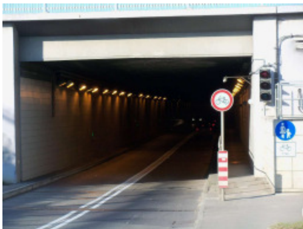
Der Flughafentunnel von Bernhausen aus gesehen: Fahrradverbot, Radfahrer sollen den extrem schmalen Gehweg nutzen
