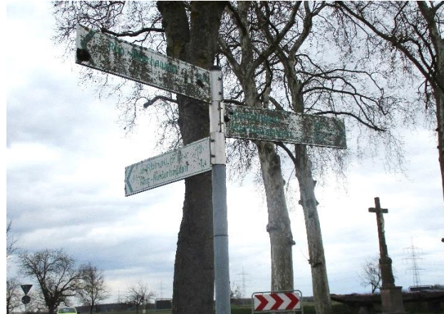
Abbildung 30 – Schräg stehender Zwischenwegweiser (links); Verdreckter Pfeilwegweiser (rechts) (eigene Fotos (VAR+, 2022))
