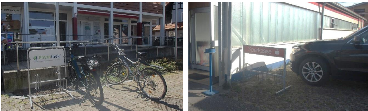
Abbildung 34 – Negativbeispiele Radabstellanlagen; links: Schlecht zugängliche Vorderradbügel; rechts: Ungenutzte Vorderradbügel (eigene Fotos (VAR+, 2022))
