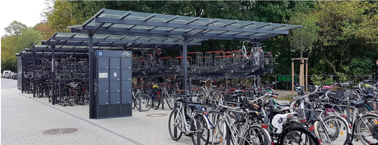
Abbildung 58 – Bike+Ride-Anlage mit einfachen und doppelstöckigen Radabstellanlagen inkl. Schließfächern (VM BW, 2019)
