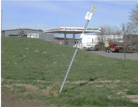
Abbildung 30 – Schräg stehender Zwischenwegweiser (links); Verdreckter Pfeilwegweiser (rechts) (eigene Fotos (VAR+, 2022))
