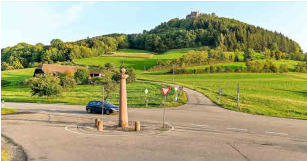
Bei der Ludwigssäule auf dem Schönberg soll eine Querungshilfe für den neuen Fuß- und Radweg gebaut werden. So können Radler von Lahr kommend durchgängig Richtung Kinzigtal fahren – ohne B415. FOTO: ENDRIK BAUBLIES
