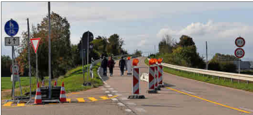
Zugunsten von Fußgängern und Radfahrern ist der motorisierte Verkehr auf der Brücke zwischen Schuttern und Kürzell eingeschränkt. FOTO: W. KÜNSTLE
