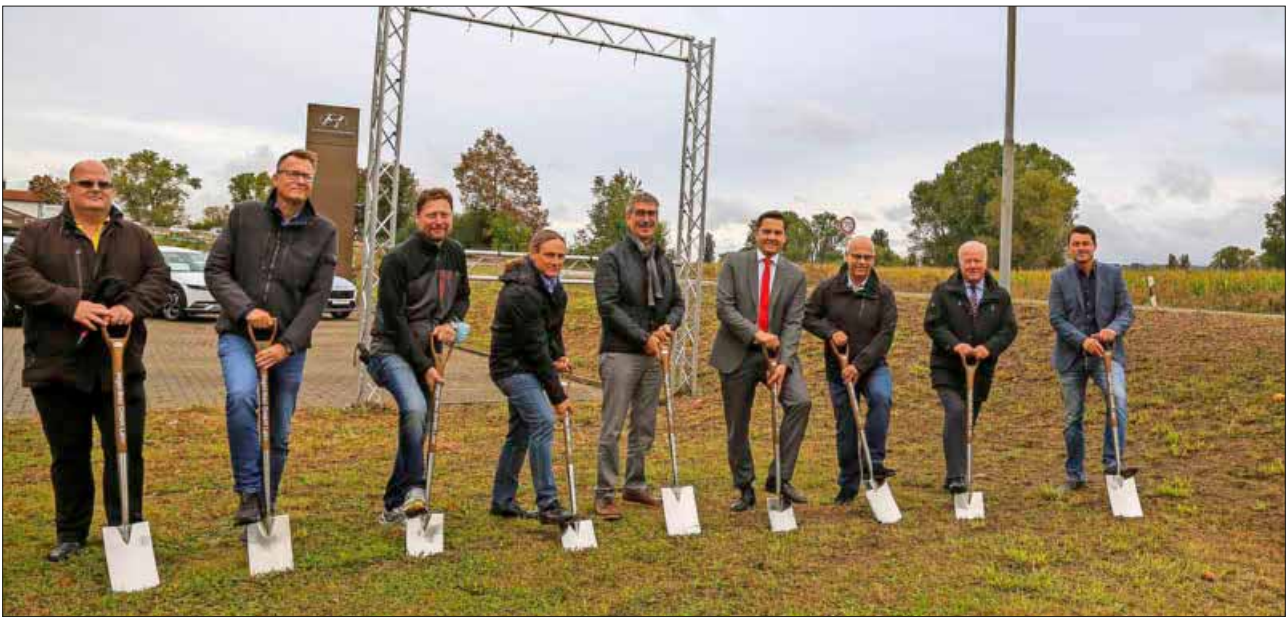
Spatenstich in Kippenheim: Bis zum Frühjahr entsteht ein neuer Rad- und Gehweg.
