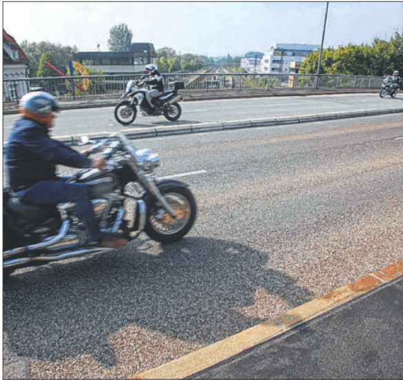
Die vierspurig ausgebaute Brücke in Eislingen soll auf zwei Spuren reduziert werden. Dafür sollen Radfahrer einen Platz erhalten.
