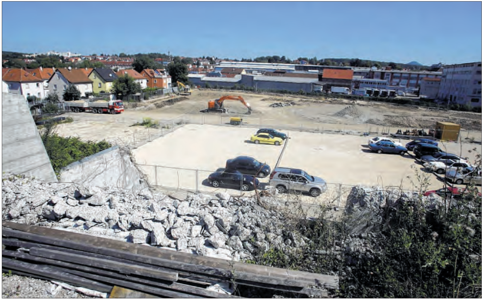
Auf dem Gelände der ehemaligen Sprudelfabrik beim Göppinger Christophsbad wurde verunreinigter Boden abgetragen.
