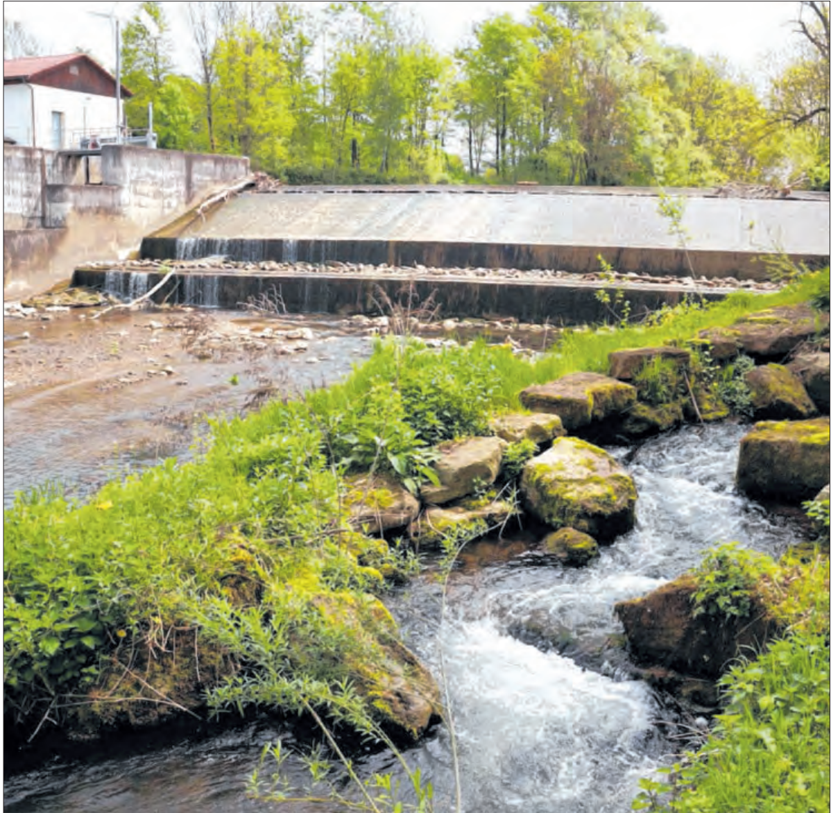
An der Fils beim Wehr zwischen Eislingen und Göppingen wird ein Aufenthaltsbereich geschaffen, so dass die Menschen besser an den Fluss kommen können. Das Ufer soll auch natürlicher gestaltet werden.
