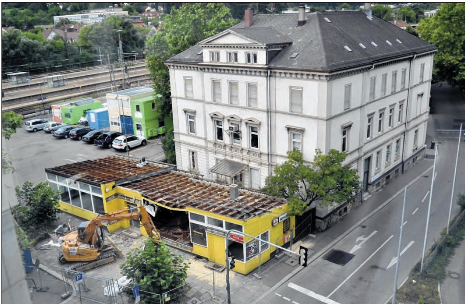
Bagger haben die heruntergekommene ehemalige Milchbar am Göppinger Bahnhof platt gemacht. Das schafft Raum für die Neugestaltung des Bahnhofsplatzes. Das benachbarte Baudenkmal Haus Gutmann ist inzwischen im Besitz der Göppinger Wohnbau. Foto: Giacinto Carlucci
