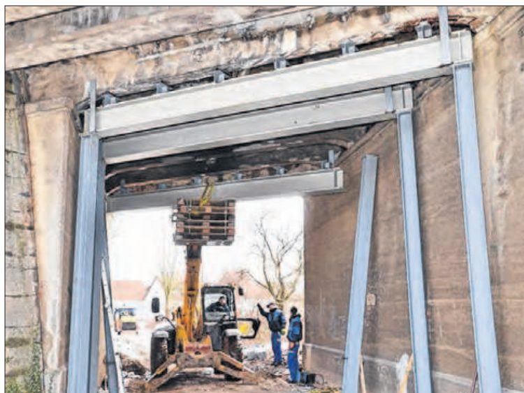
Mit einigen Stahlträgern wurde ein Teil der Bahn-Brücke bei Faurndau jetzt repariert, weil der Neubau sich weiter verzögert. Foto: Giacinto Carlucci
