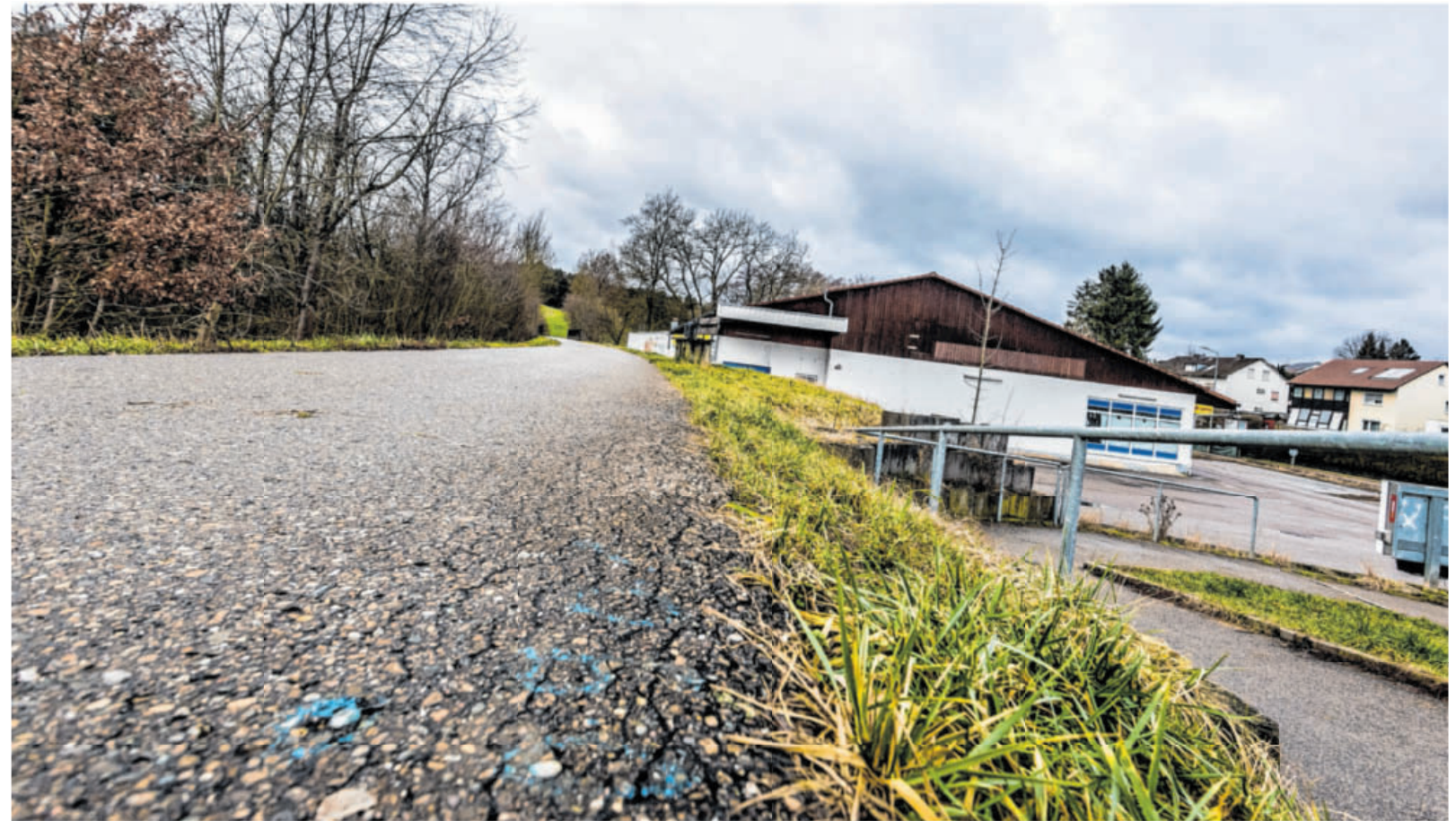
Der Radweg soll in Richtung Süden verlegt werden. Er wird künftig an das neue Marktgebäude anschließen.
