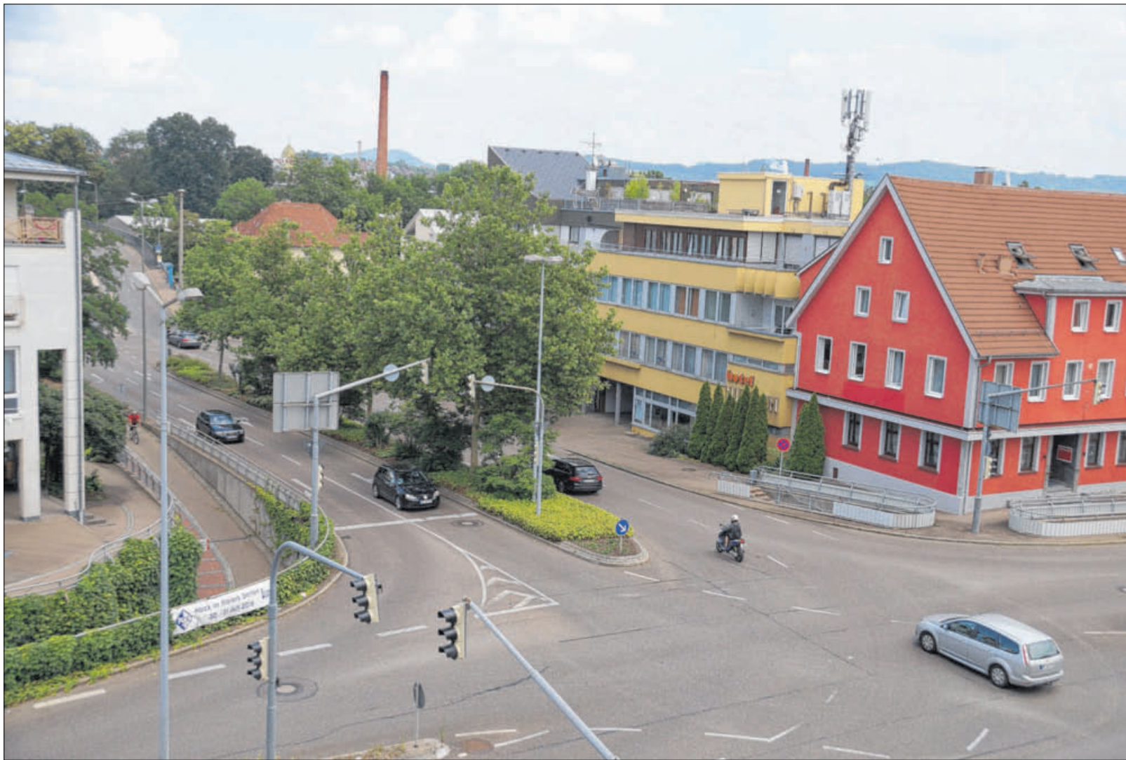
Die Verkehrssituation nach dem Abbiegen von der Stuttgarter Straße auf die Eisinger Hauptstraße gilt als problematisch. Daher tut sich Eisingen mit der Reduzierung der vier Spuren zugunsten von Radwegen auf der Bahnbrücke (im Hintergrund) schwer.
