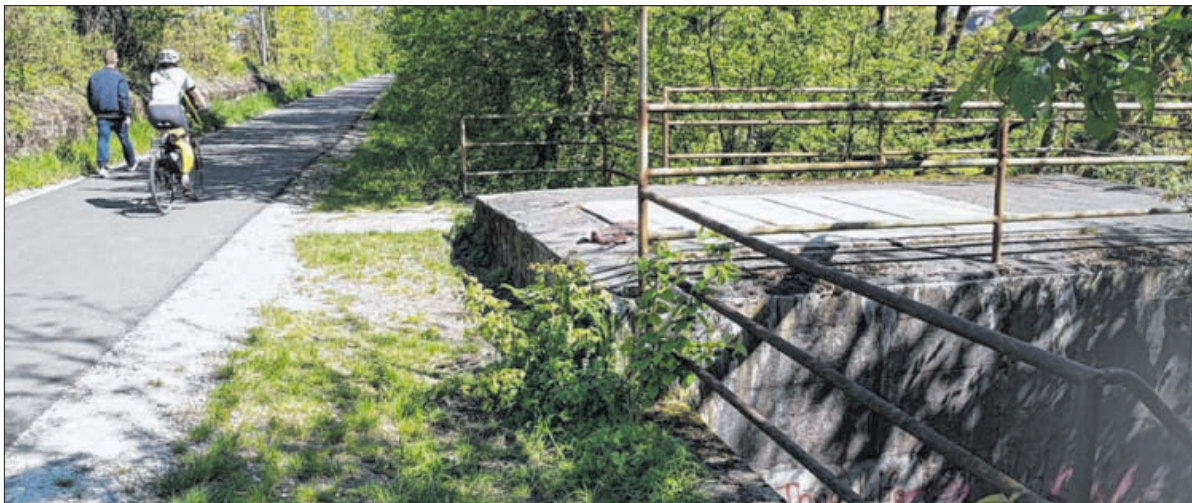
Am Radweg an der Filsstraße in Eislingen wird die neue Insel der Route der Industriekultur eingerichtet. Dort befindet sich die ehemalige Wasserentnahmestelle (r.) der Firma Fleischer.
