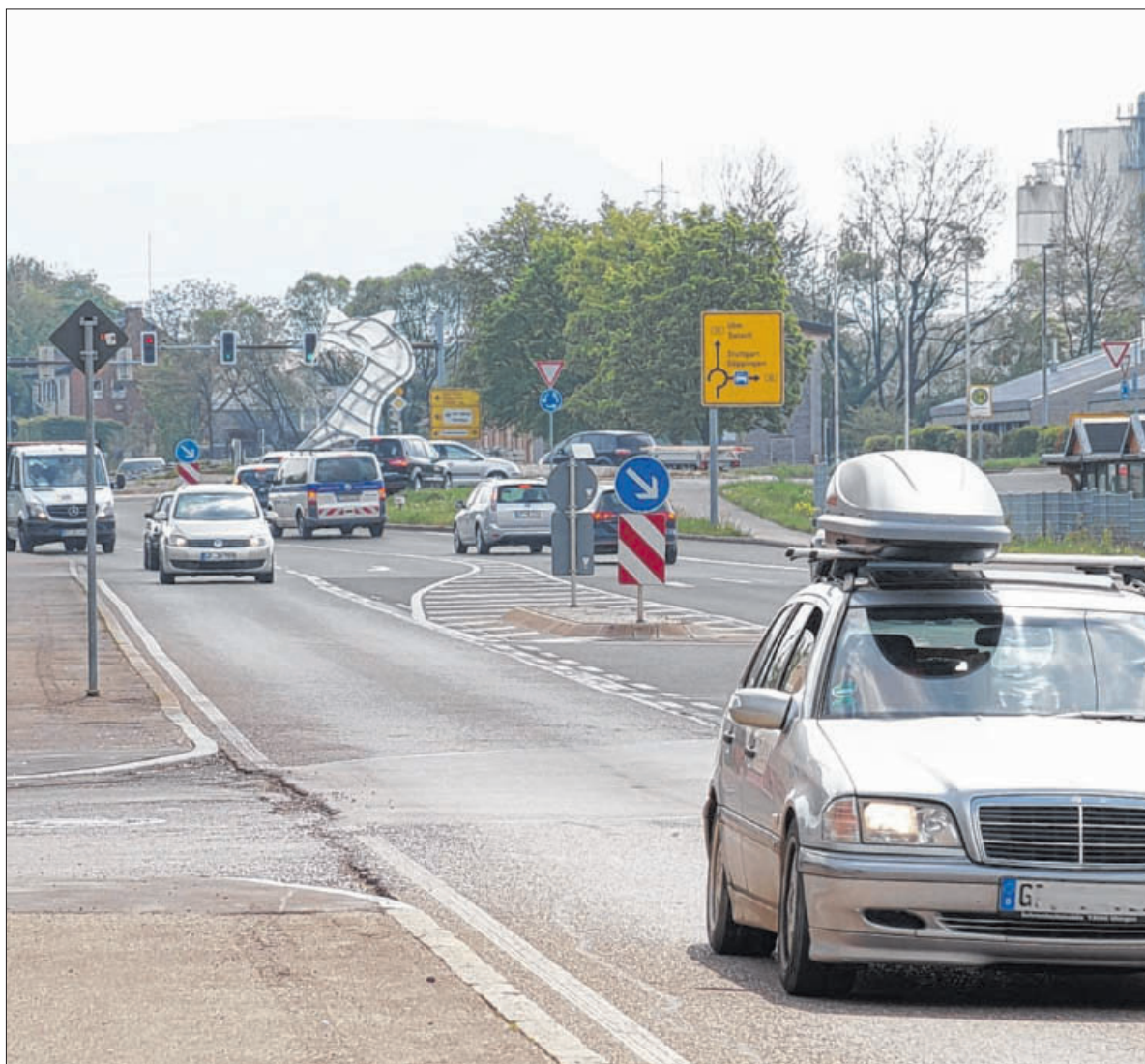
Die Ulmer Straße am Ostende von Eislingen ist immer noch auf Verkehrsmengen ausgelegt, die dort heute nicht mehr fahren. Deswegen wird die Straße im nächsten Jahr zurückgebaut. Foto: Staufenpress
