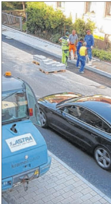
Bis Ende Oktober wird an der Lorcher Straße gearbeitet. Foto: Staufenpress
