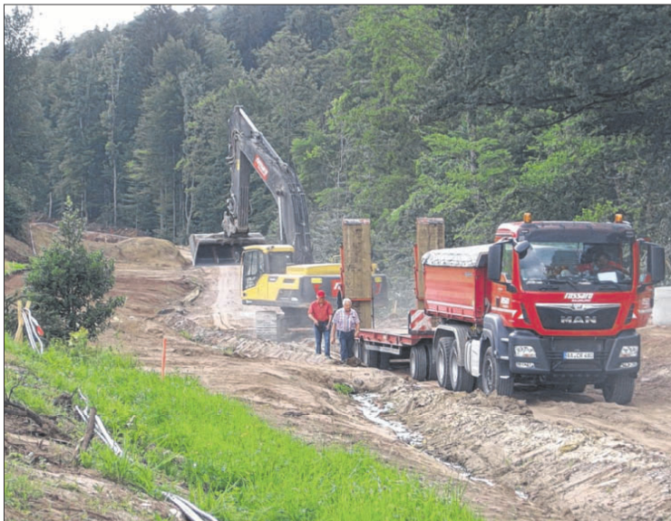
Gleich nach dem Ortsausgang von Nassachmühle ebnen und verdichten Arbeiter den Boden für einen neuen Straßenbelag. Weiter nördlich sind die Männer schon weiter und verlegen Drainagen neben der geplanten Strecke. Foto: Tobias Flegel
