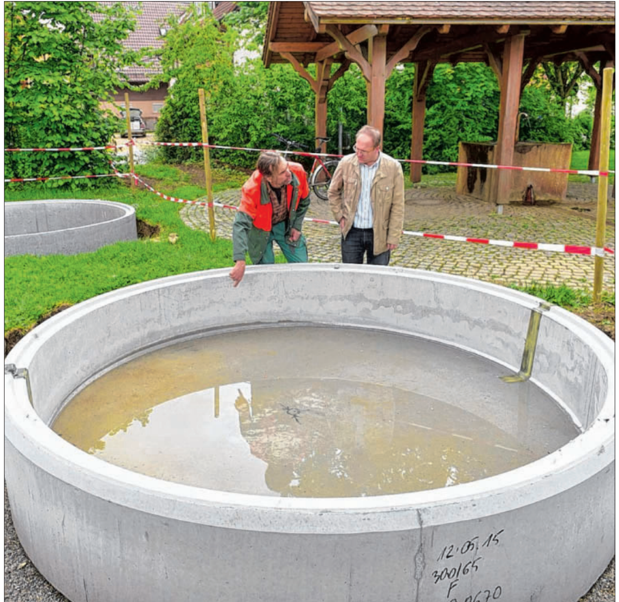
Noch eine Baustelle: Bürgermeister Jochen Reutter (rechts) und Bauhelfer Jürgen Kehm am künftigen Kneippbecken von Hattenhofen. Im Hintergrund links der Ring für den Barfußpfad, rechts der Sauerbrunnen.
