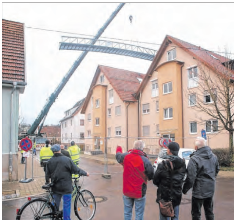
Zwischen den Hausdächern schwebt der Steg am Haken des Krans ein.
