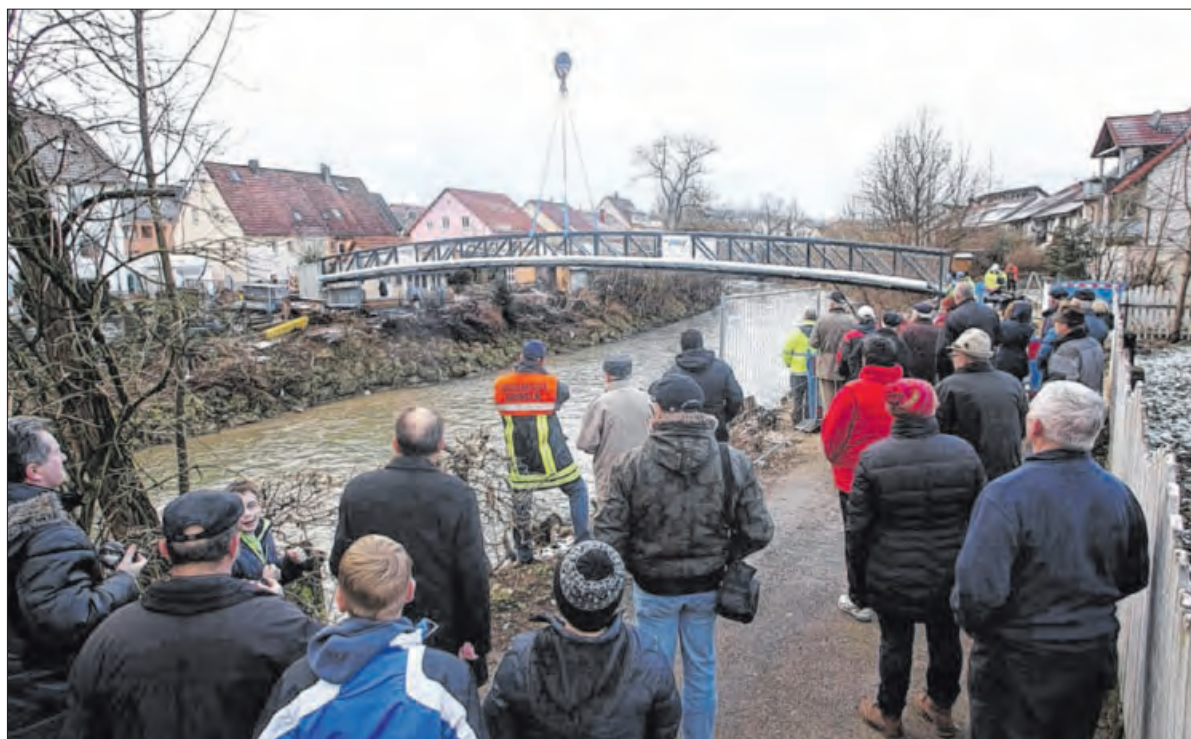
Zahlreiche Schaulustige verfolgen, wie die Brücke an ihren endgültigen Platz herabgesenkt wird.
