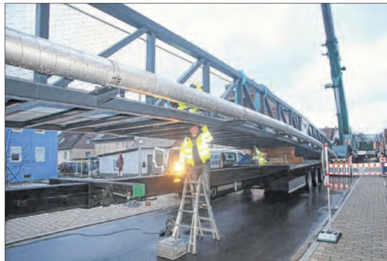
Maßarbeit: Gekonnt zirkelt Kranführer Rolf Sauter das 16 Tonnen schwere Stahlteil zwischen den Uhinger Häusern hindurch.
