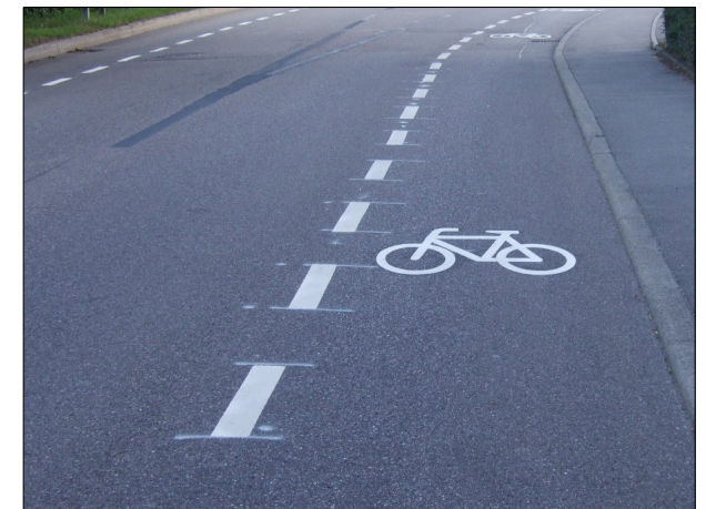
Schutzstreifen auf der Carl-Benz-Straße
