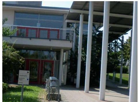
Eine an sich gute Anlage an der Filharmonie: Warum nicht unter dem Dach?
