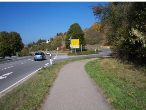
Von Rohrdorf kommend Richtung Ebhausen: Der Radweg quert die Einmündung nicht direkt
