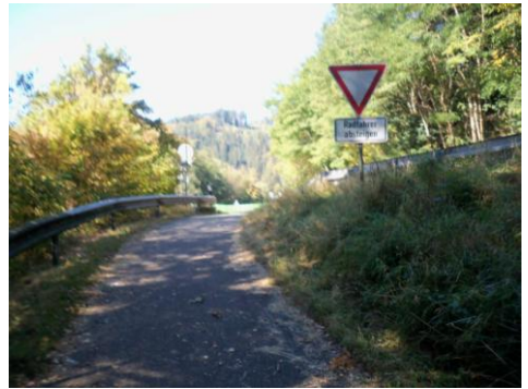
„Radfahrer absteigen“. Dieser Hinweis ist überflüssig
