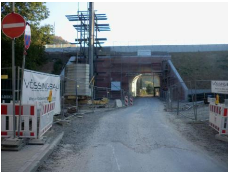
Baustelle im Herbst 2011 in der Herrenberger Straße in Nagold.
