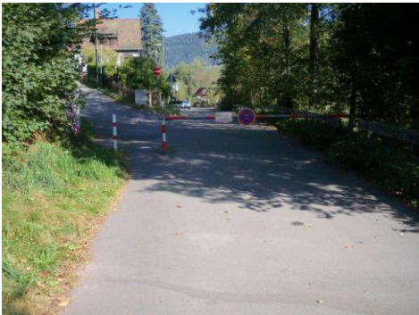
Schranke am südlichen Ortsrand von Calw-Hirsau, mit zu schmalen Durchlass
